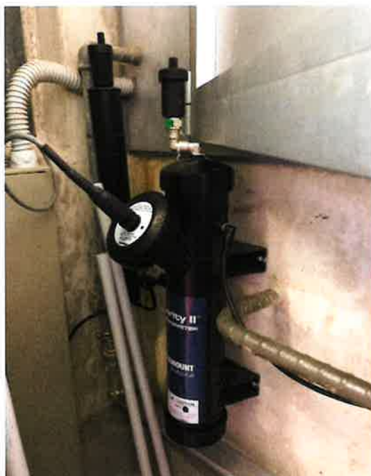
Figura 5 - Torbidimetro attualmente installato al serbatoio Orgnana
