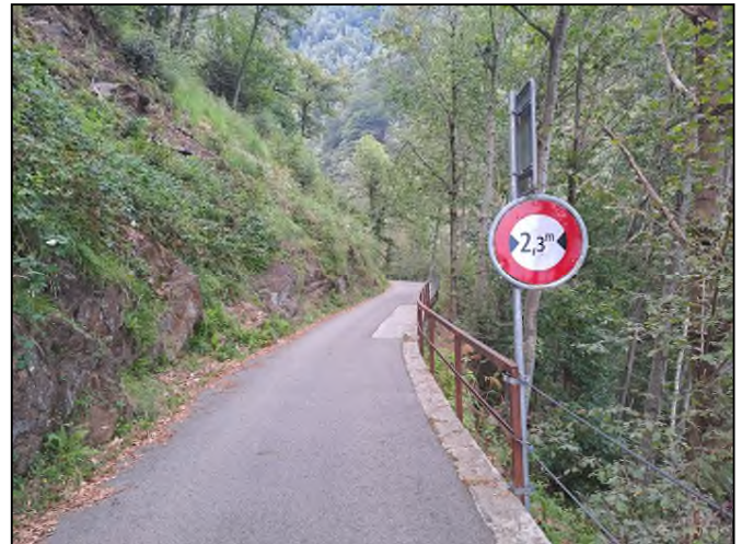
Figura 2: Accesso zona di intervento
