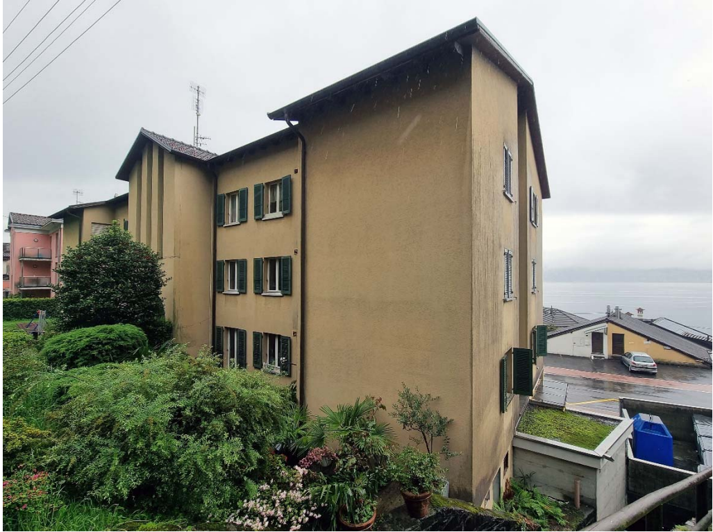
- La facciata sud
