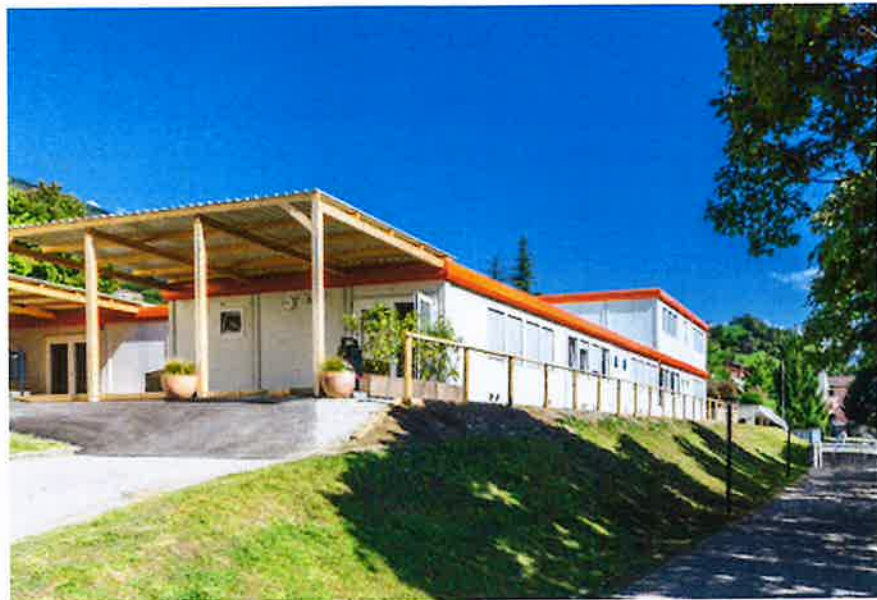
Stabile scolastico realizzato a Bioggio
