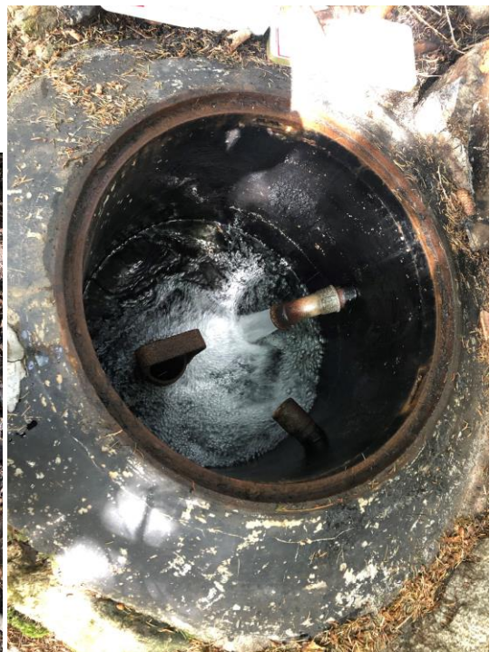
Fig. 3: Immagini dello stato di fatto Camera di rottura al 27.06.2022
