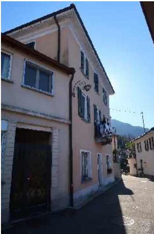
foto 1 Vista da Nord
