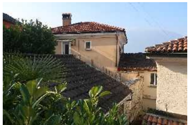
foto 4 Vista da Sud/Est
