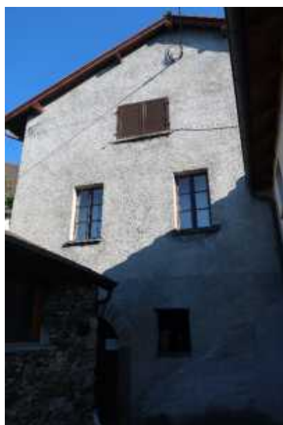
foto 3 Vista da Ovest
