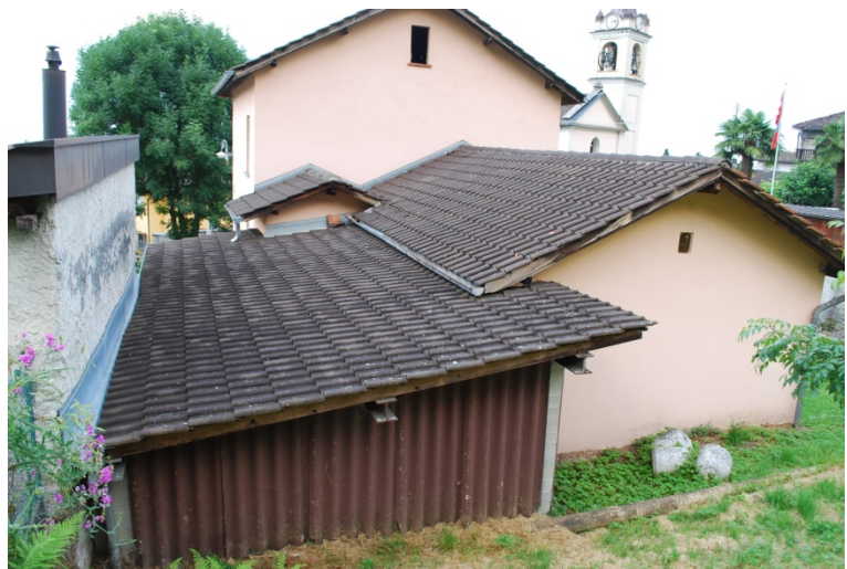
foto 5 Vista sulla tettoia
