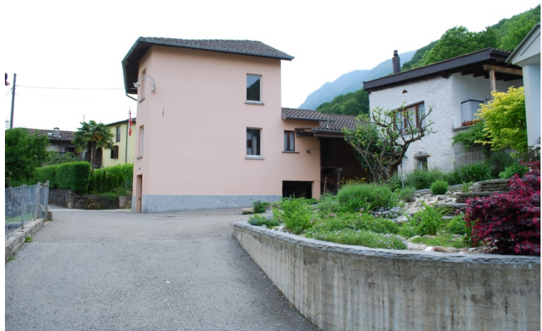
foto 3 Vista da Nord/Est
