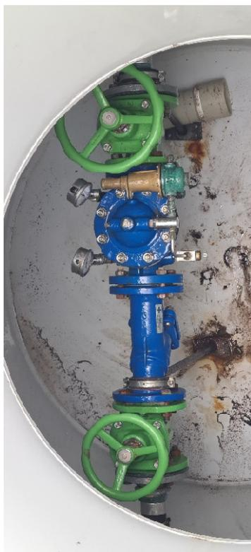
Figura 14: Riduttore di pressione esistente
